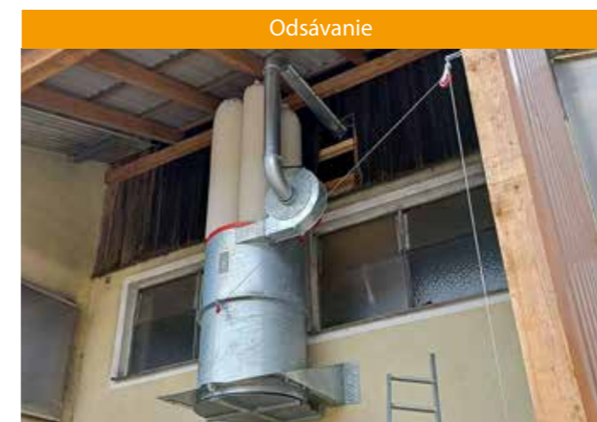
Odsávanie s automatickým odstraňovaním prachu
